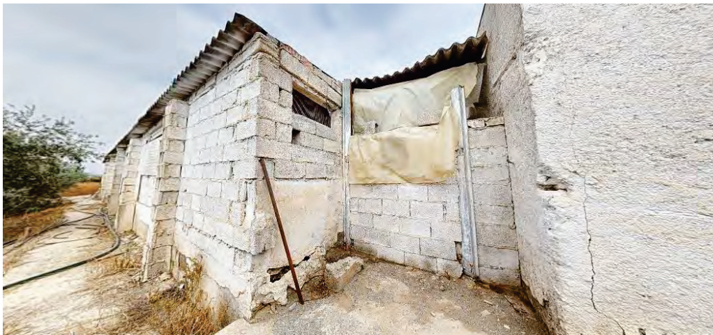
Nave 2: Vista Sur:
