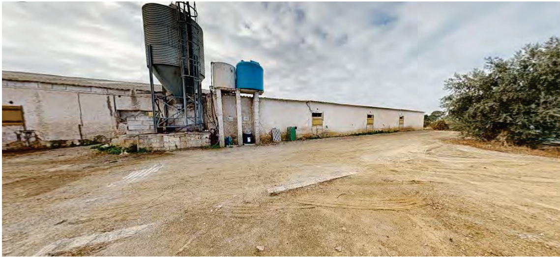
Nave 2: Vista Norte:
