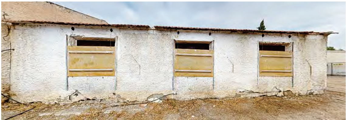
Nave 1: Vista Sur:
