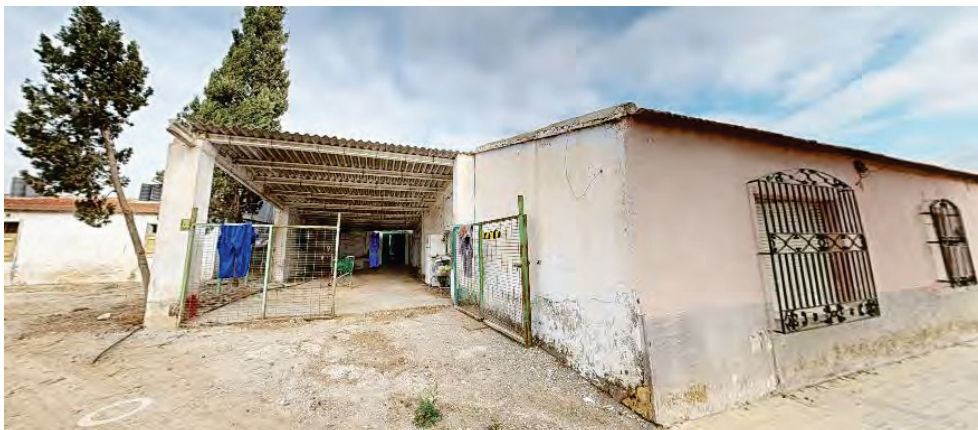
Dependencias anexas: Vista Sur:
